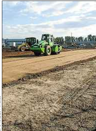
Le site en chantier, à Bruges.
